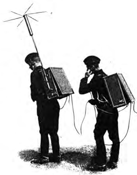
Bild 2. Die Station im Betrieb während des Marsches.
