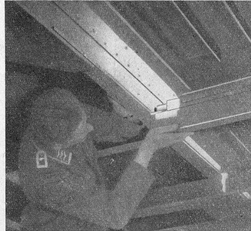
Bild 53 und 54. Plattform (IV/6) am Bedienungshaus einstecken und verriegeln.
